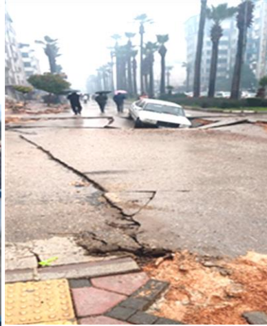
Görsel 12: Deprem Sonrası Yollarda Oluşan Hasarlar
